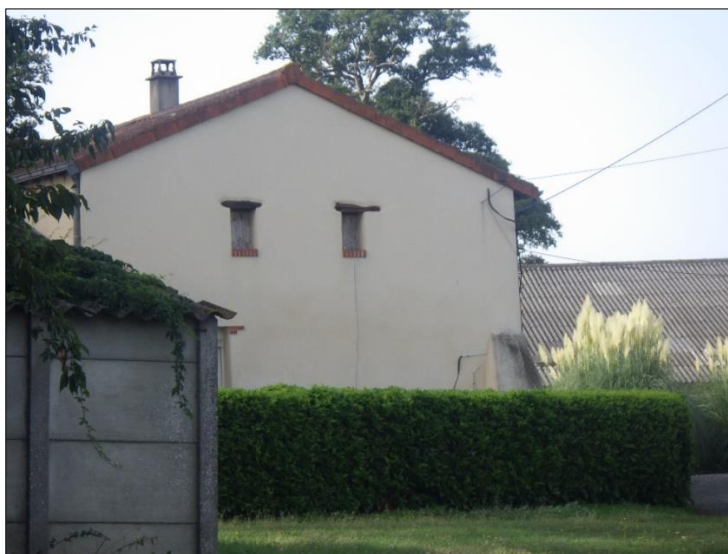
Pignon de la ferme sur lequel le nichoir sera installé
