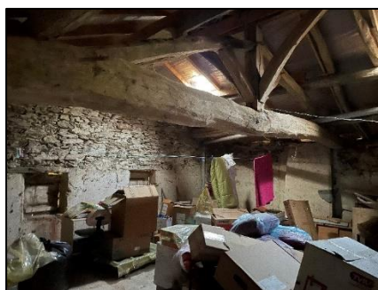
Grenier du bâtiment d'habitation de la ferme de la Touche
