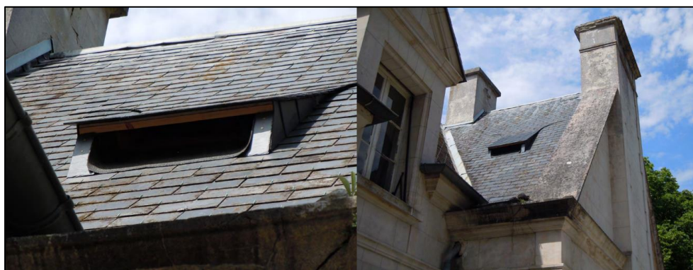
Exemple de mise en place d'une chiroptière (source : SFPEM)
